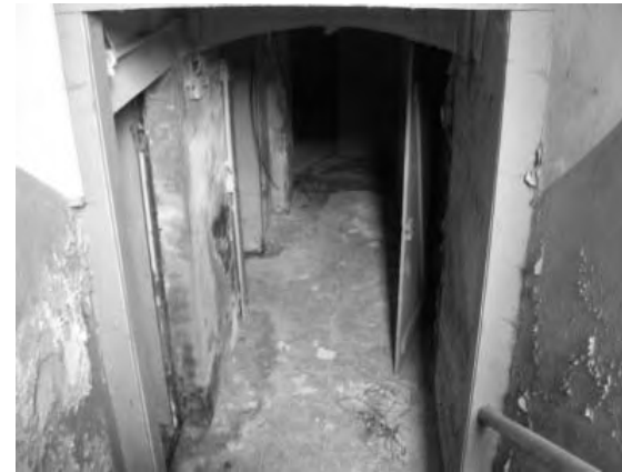
Unter dem Haupthaus befinden sich ausgedehnte Kellerräume
