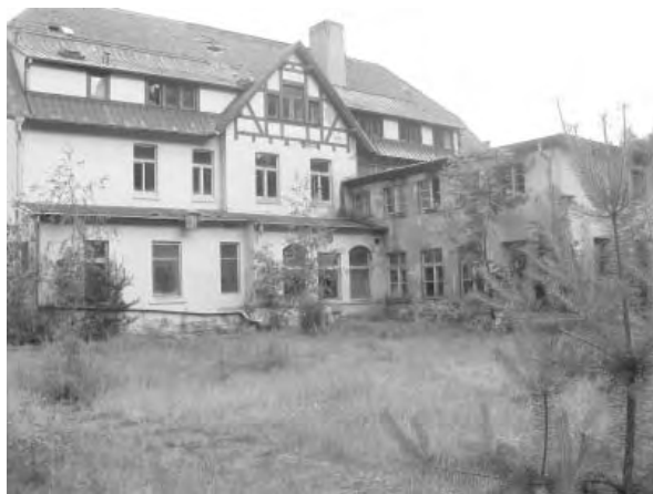
Haus „Seefrieden“: Die Gebäude sind schon vor Jahren verlassen worden.
