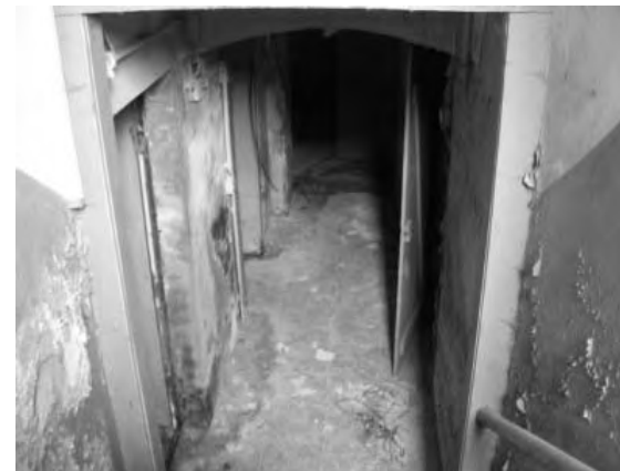
Unter dem Haupthaus befinden sich ausgedehnte Kellerräume
